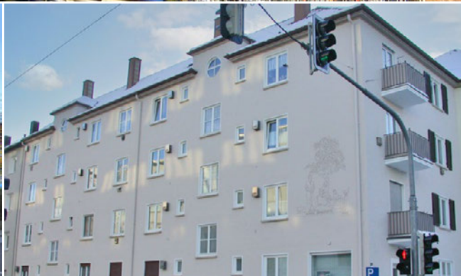
Es geht voran auf der Baustelle UhlandEck. Darunter die nicht mehr sanierungsfähigen Gebäude Ecke Söflinger Straße/Uhlandstraße vor dem Abriss.
