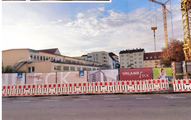
Die Baustelle UhlandEck in der Weststadt macht gute Fortschritte.
